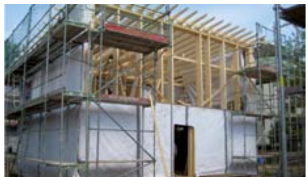
Abb. 185 Fertigstellung Holzrahmenbau
