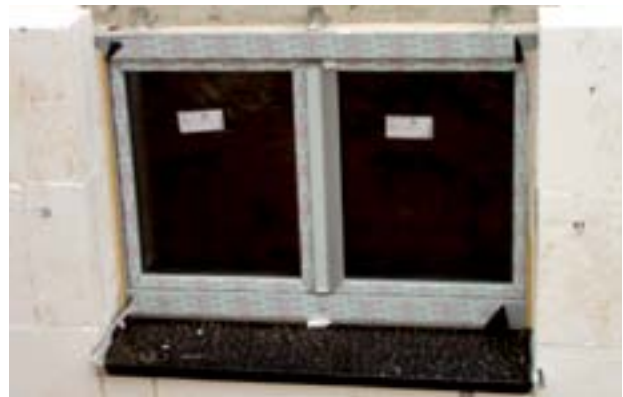
Abb. 194 Einbau passivhaustaugliches Fenster
