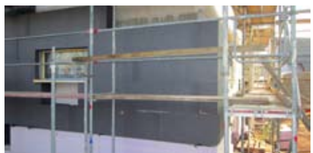
Abb. 178 Installation der Außendämmung
