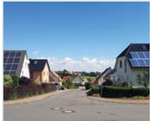
Abb. 8 EFH mit PV-Anlage
