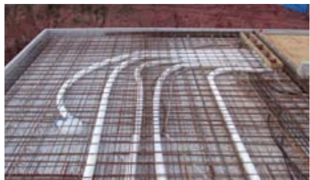
Abb. 181 Installation der Lüftungsleitungen © SAENA
