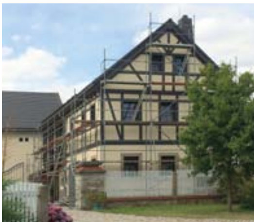
Abb. 10 Beispiel für Fachwerkhauassanierung
