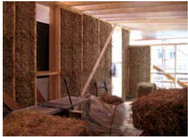
Abb. 187 Einbau der Strohballen in die Gefache
