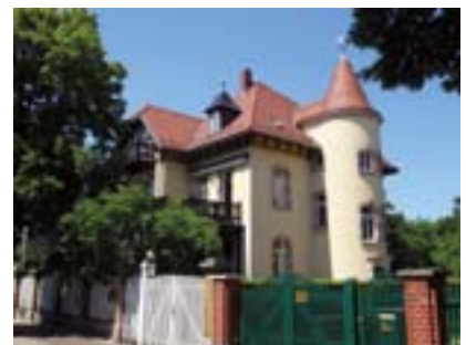
Abb. 3 Beispiel für sanierte Villa
