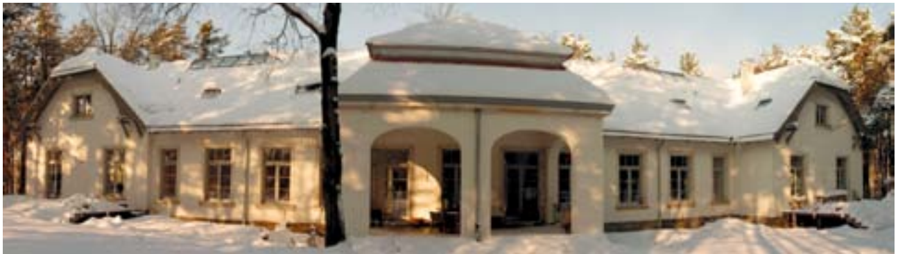
Abb. 198 Gebäude nach der Sanierungsmaßnahme
