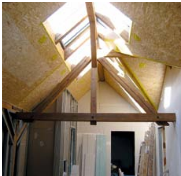
Abb. 200 Einbau von Dachfenstern im Firstbereich
