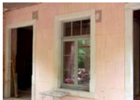
Abb. 199 Fenster und Außendämmung © SAENA
