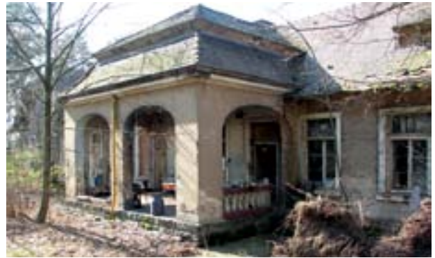
Abb. 197 Gebäude vor der Sanierung
