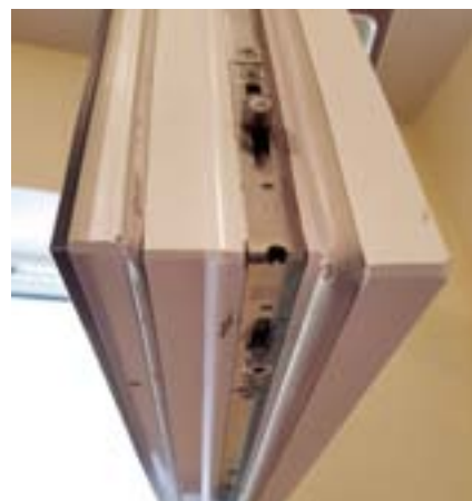
Abb. 68 umlaufende Pilzkopfverriegelung © SAENA
