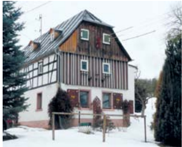
Abb. 202 Gebäude vor der Sanierung
