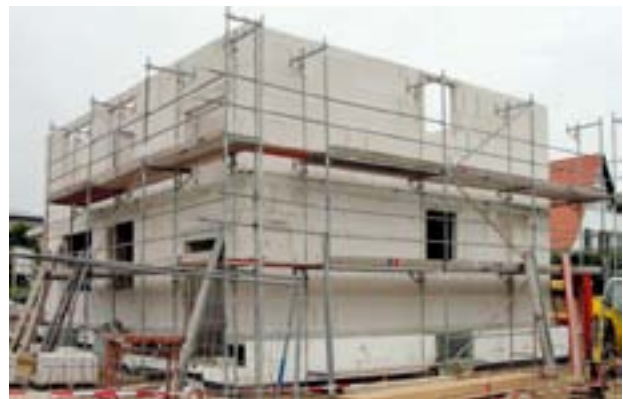
Abb. 193 Gebäude während der Bauphase
