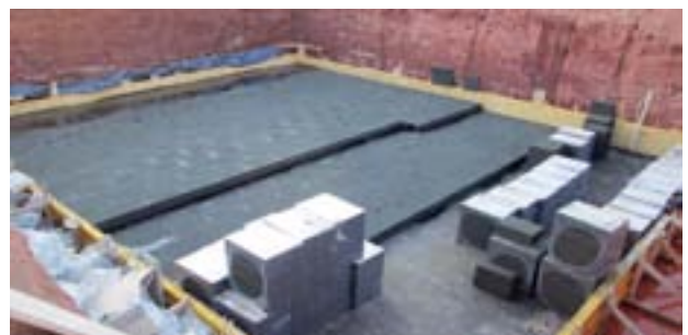
Abb. 176 Schaumglasplatten-Verlegung unter Bodenplatte
