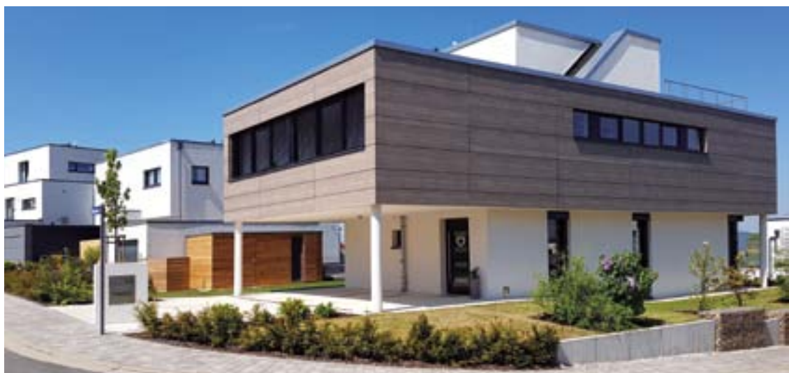
Abb. 58 Neubau Fensterbänder mit Raffstoreanlagen © SAENA
