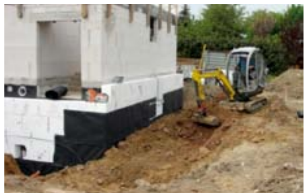
Abb. 195 Außenwand mit Dämmung
