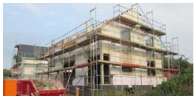
Abb. 177 Abschluss der Rohbauarbeiten
