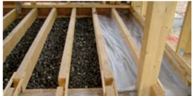
Abb. 184 Erstellung Holzbodenplatte auf Schaumglasschotter © SAENA
