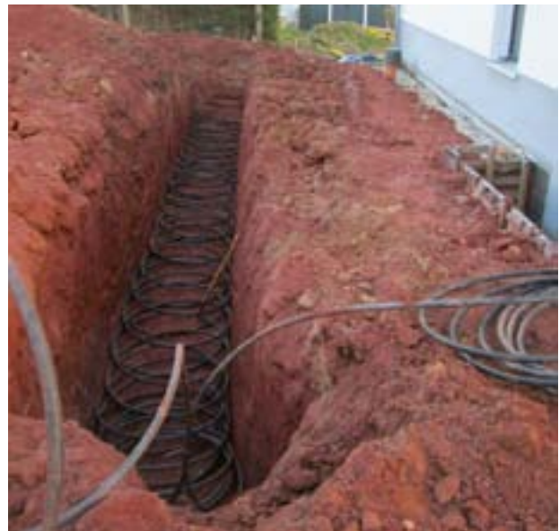
Abb. 180 Verlegung des Ringgrabenkollektor © SAENA
