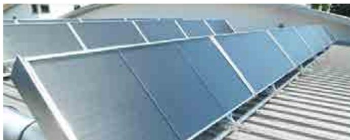
Abbildung 49: Solar-Luftkollektoranlage (aufgeständert)
