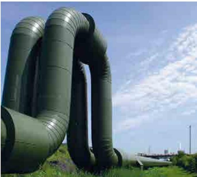
Abbildung 40: Oberirdische Fernwärmetrasse
