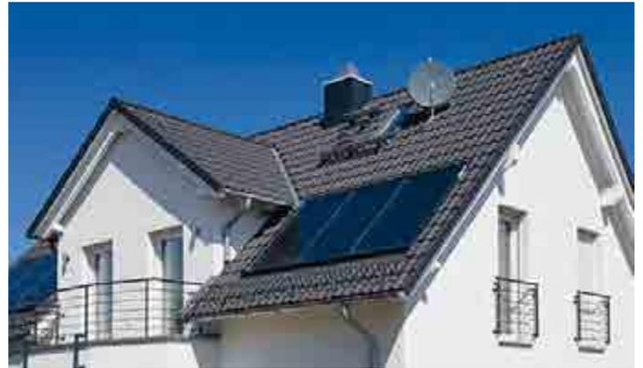
Abbildung 51: Kleine Solarthermieanlage (Indach-Montage)
