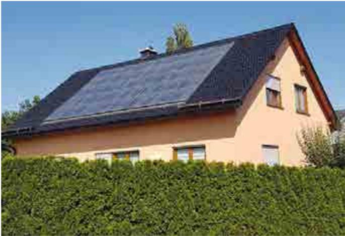
Abbildung 44: Solarthermieanlage (Indach-Montage)
