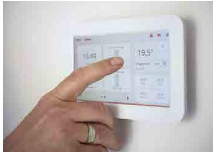
Abbildung 69: Touch-Display zur Heizungssteuerung
