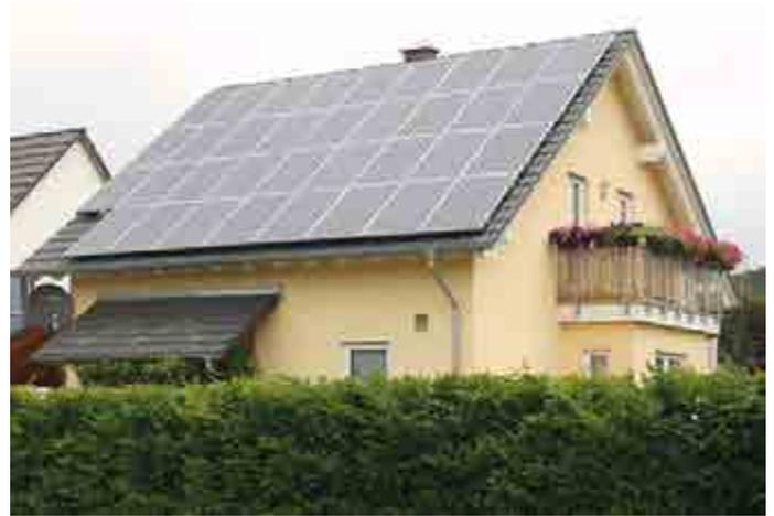
Abbildung 45: Photovoltaikanlage (Aufdach-Montage)
