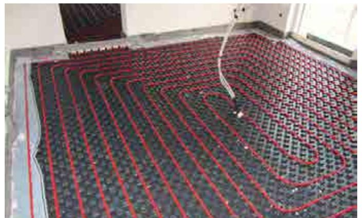
Abbildung 63: Einbau einer Fußbodenheizung
