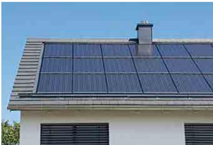
Abbildung 54: Photovoltaikanlage (Indach-Montage)
