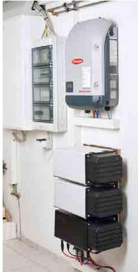
Abbildung 55: Modularer Stromspeicher mit PV-Wechselrichter
