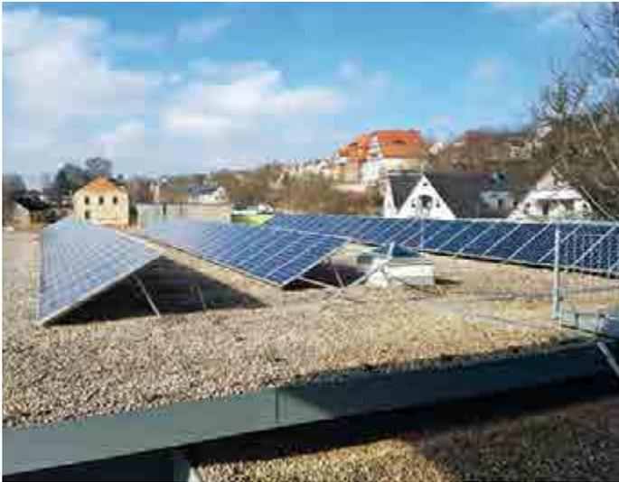
Abbildung 52: Aufgeständerte PV-Anlage auf einem Flachdach
