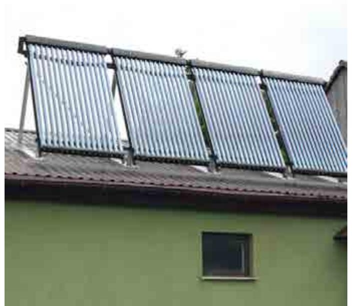
Abbildung 47: Vakuümrohrenkollektor (aufgeständert)
