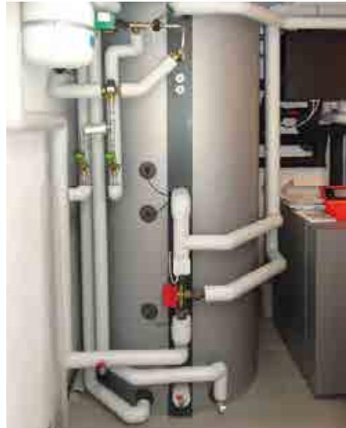
Abbildung 1: Neue Heizungsanlage mit Sole-Wasser Wärmepumpe und Pufferspeicher
