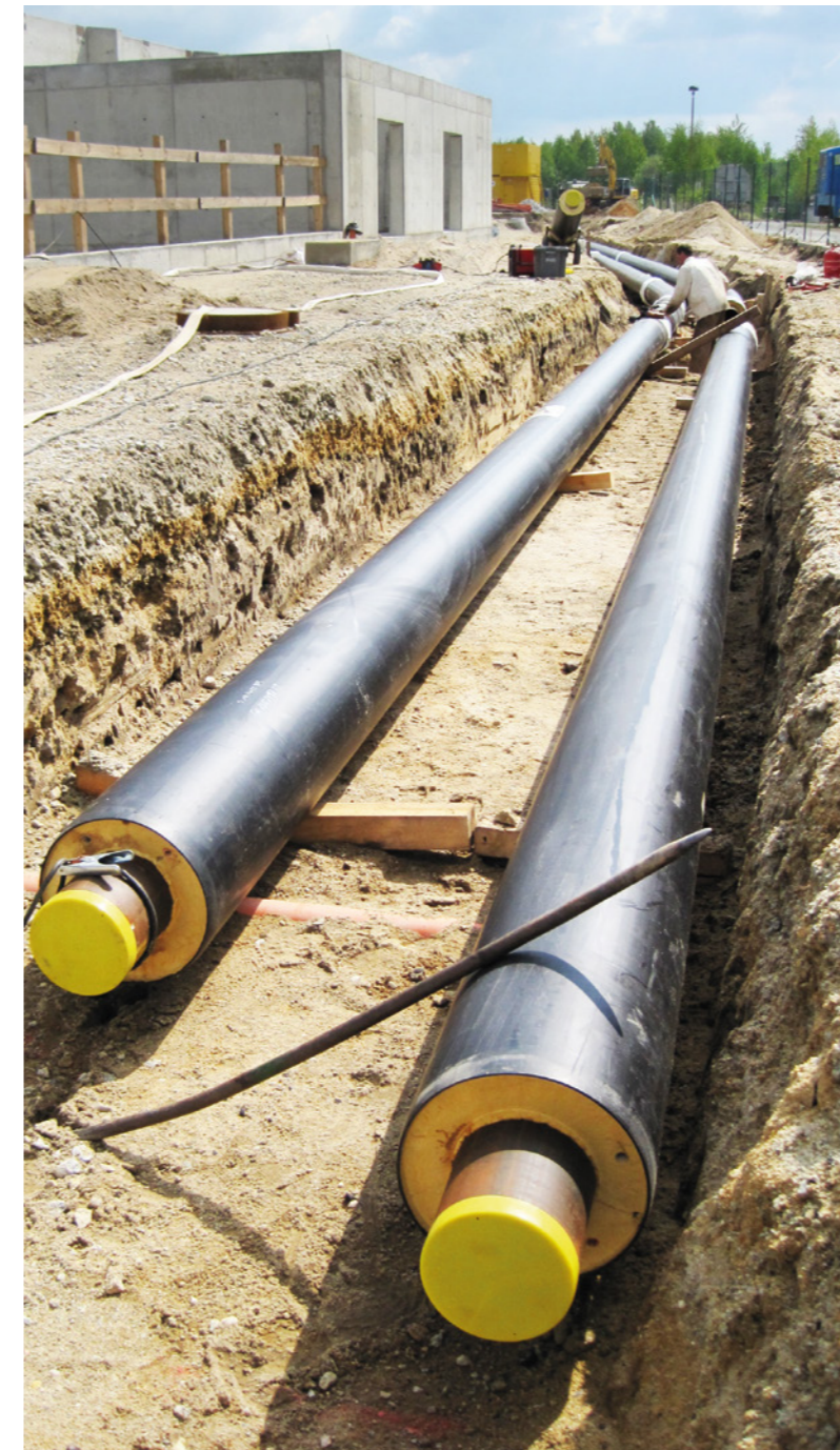
Budowa linii ciepłowniczej / Bau der Heizstraße
