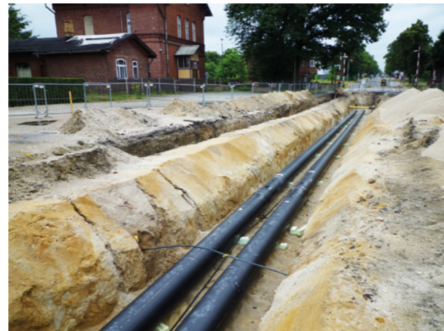
Układanie rur linii ciepłowniczej / Verlegen der Heizröhre
