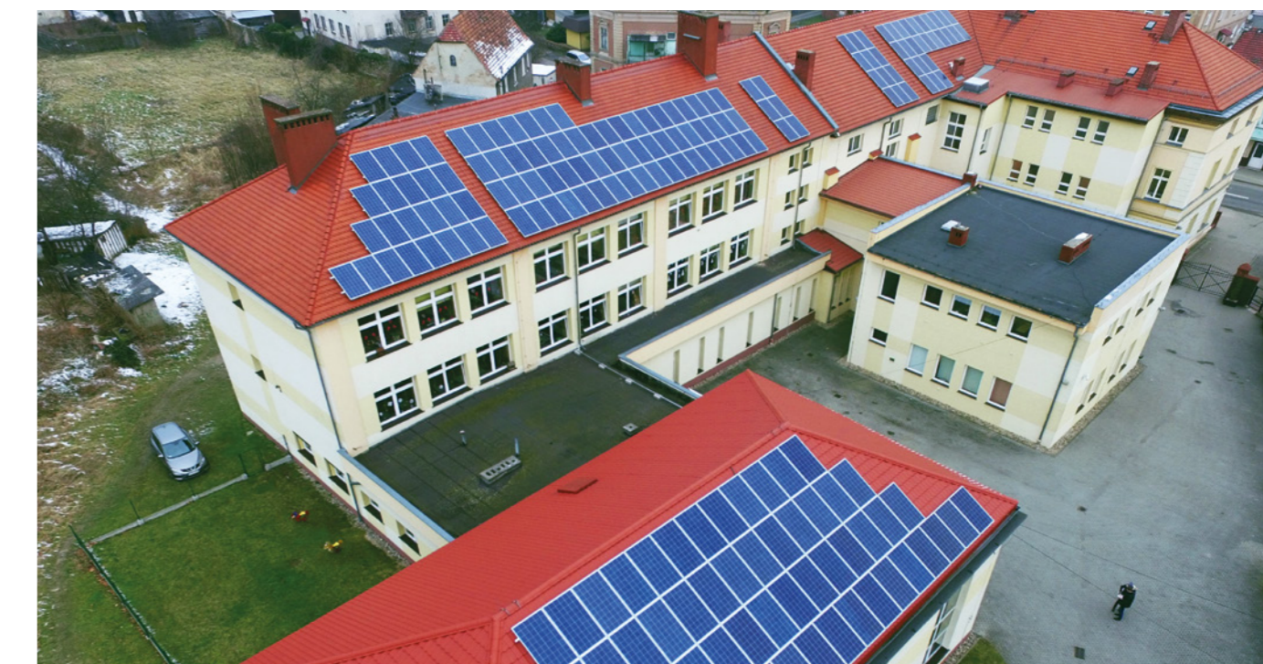
Panele fotowoltaiczne na dachu Szkoły Podstawowej nr 1 w Olszynie / Photovoltaik-Anlagen auf dem Dach der Grundschule Nr. 1 in Olszyna
