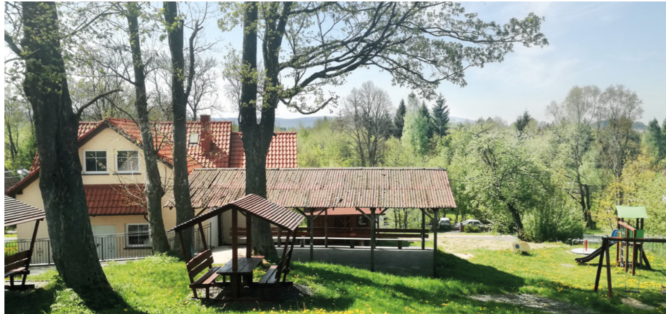
Zabudowania Świetlicy Wiejskiej w Radoniowie / Bauten des dörflichen Gemeinschaftsraumes in Radoniów
