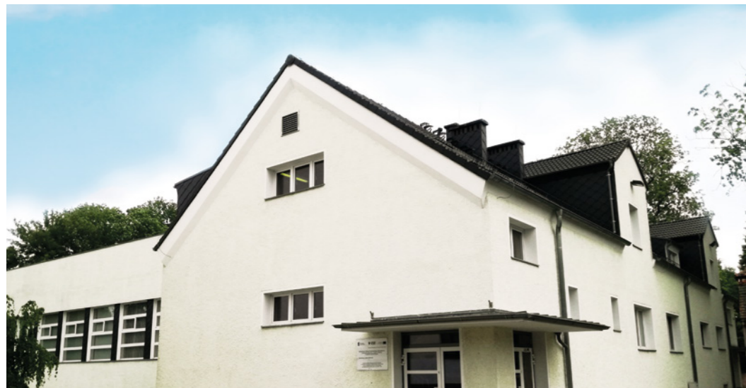
Dobudowana część Szkoły Podstawowej w Gierattowcu / Anbau der Grundschule in Gierattowiec
