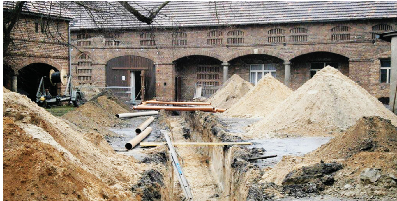
Prace ziemne przy budowie lokalnej linii ciepłowniczej / Graben für die Nahwärmeleitung
