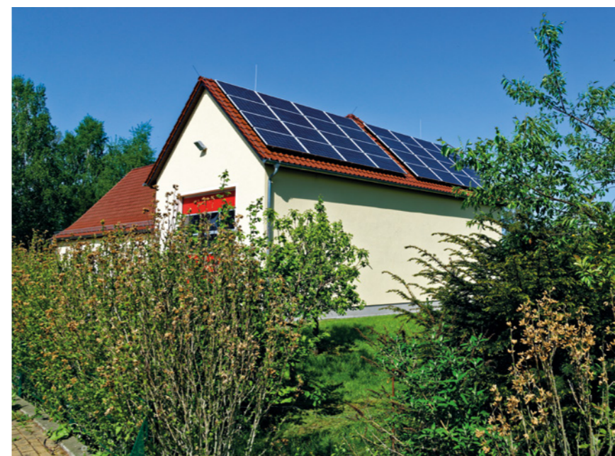
Remiza z instalacją fotowoltaiczną / Feuerwehr mit PV-Anlage
