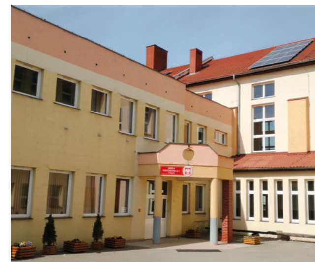
Budynek Szkoły Podstawowej nr 1 w Olszynie / Gebäude der Grundschule Nr. 1 in Olszyna
