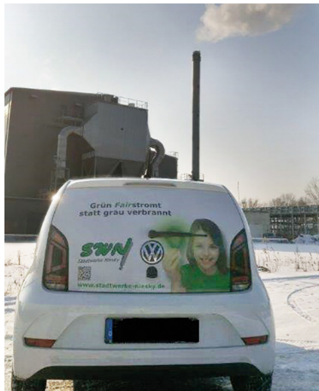
Centrala ciepłownicza / Heizzentrale
