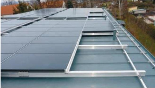
Abbildung 38: Dachparallele Montage auf Stehfalzblech (Einlegesystem zweilagig)
