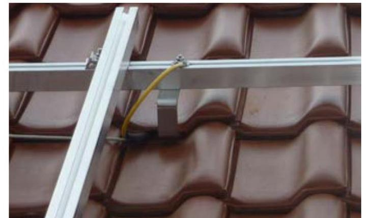
Abbildung 35: Anschluss Potentialausgleich am Befestigungssystem
