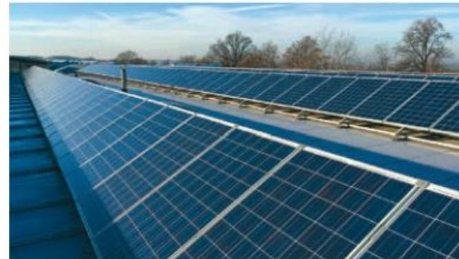
Abbildung 43: Aufgeständerte Montage mit Aluminium-Gestellen auf Blechdach
