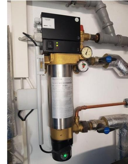
Elektr. Ladestation 2 kW für Warmwasserbereitung
