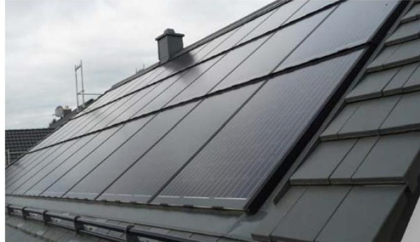
Abbildung 45: Fertige Indach-Anlage mit Glas-Glas-Modulen
