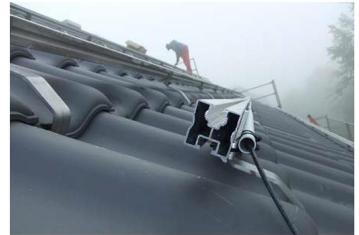
Abbildung 23: Verlegung von Solarkabeln in Schutzrohren
