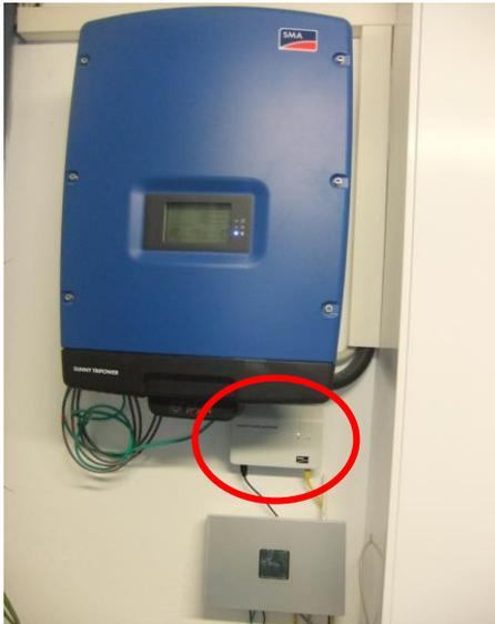
Wechselrichter und Energiemanager u.a. zur Steuerung der Funksteckdosen
