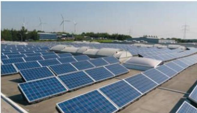
Abbildung 41: Aufgeständerte Montage mit Kunststoffwannen
