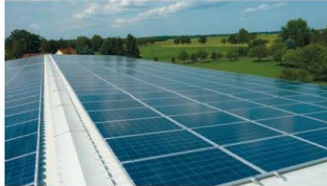
Abbildung 39: Dachparallele Montage auf Trapezblech
