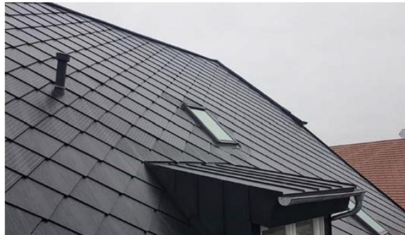
Abbildung 47: Solardachziegel in Dachschieferoptik
