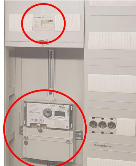
Digitaler Energie- und Zweirichtungszähler im Schaltschrank
