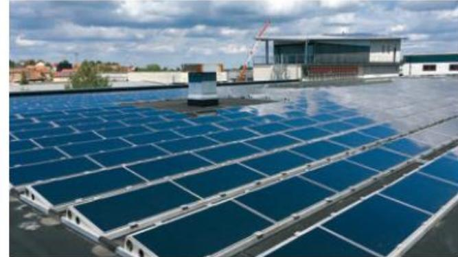
Abbildung 40: Aufgeständerte Montage mit Kunststoffwannen
