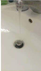
Bild 5: Die Durchflussmenge nach der Einregulierung.
